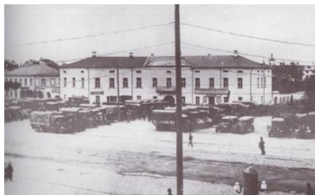
Здание кинотеатра «Вулкан»
