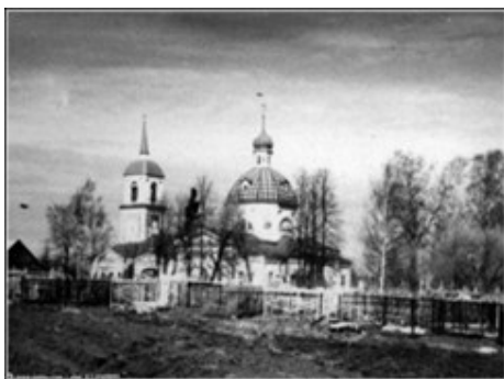
Село Шипулино. Церковь Воскресения Словущего и погост
